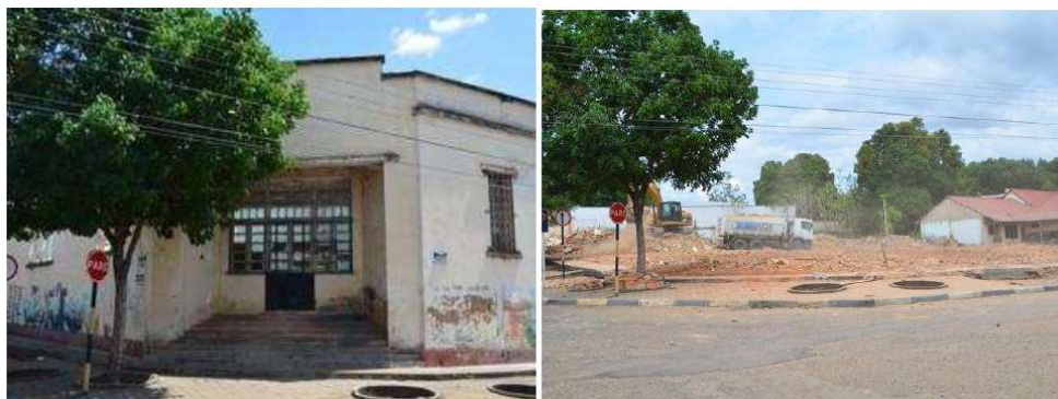
Figura 9: Hospital Nossa Senhora de Fátima, antes e depois da demolição, 2015.
