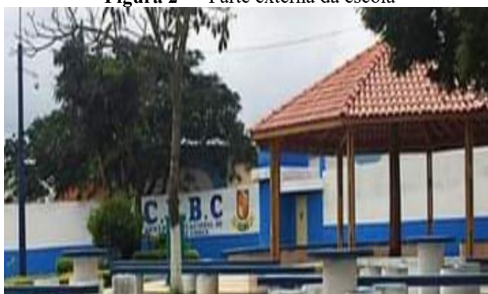
Figura 2 — Parte externa da escola
