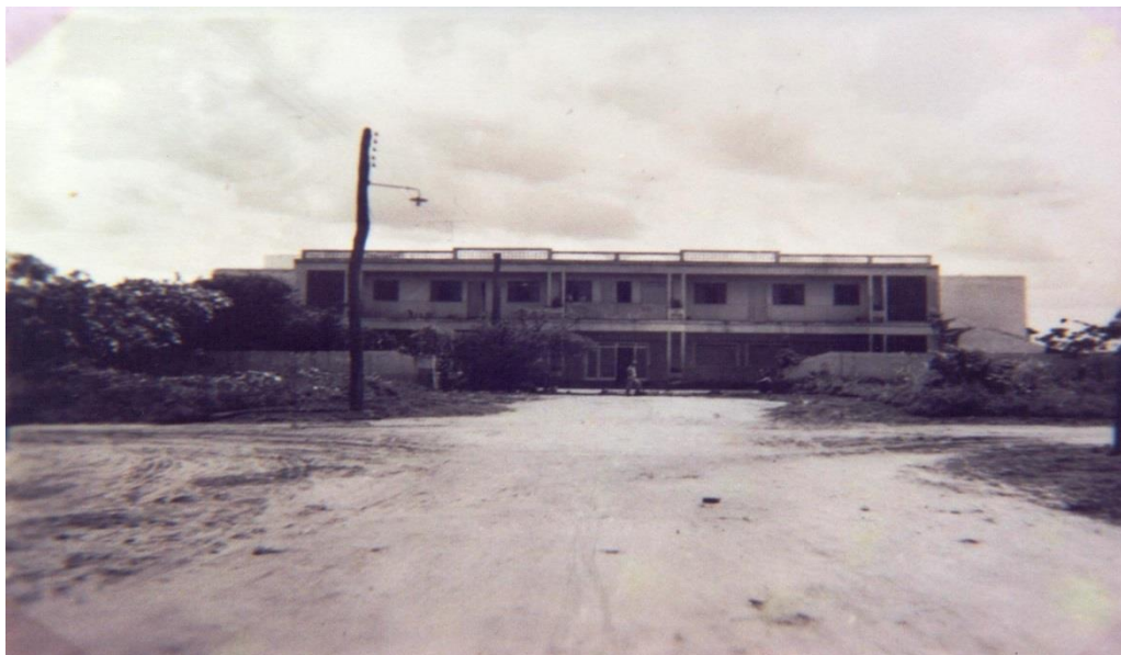
Imagem 02: Prédio em construção bem avançada.
