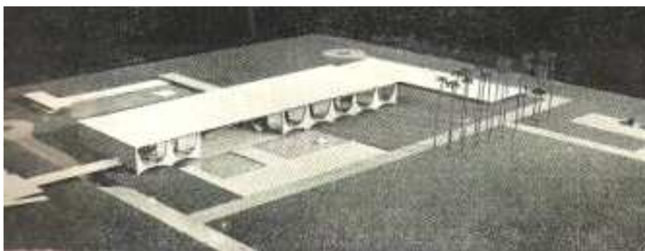
Fig. 12 – Palácio da Alvorada, 1º edifício (em construção) no local definitivo da nova Capital. Fonte: idem
