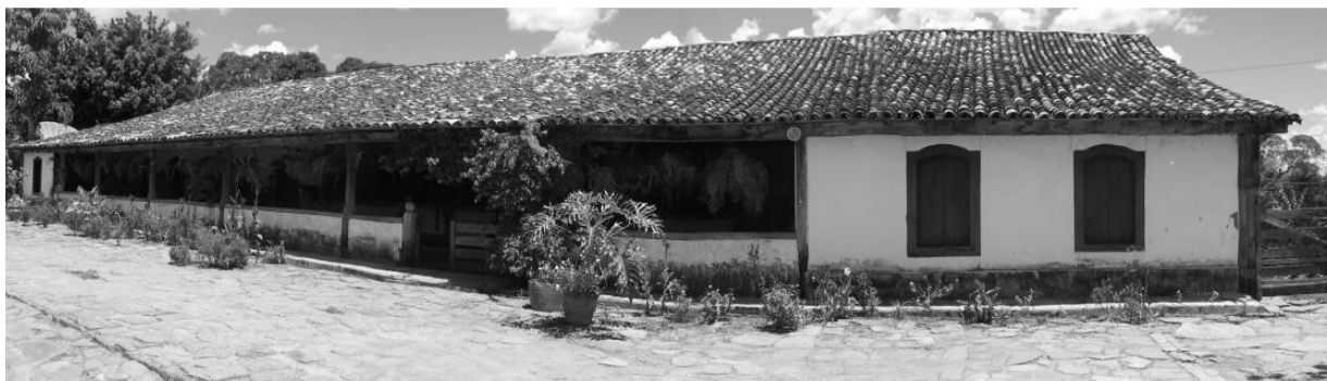
Foto 3 – Sede da Fazenda Babilônia. Casa e Engenho. A direita o quarto de hóspedes e, no extremo esquerdo, temos a capela. A varanda envolve a casa e parte do engenho. Foto: Oscar Luís Ferreira.
