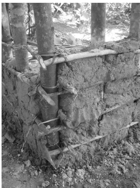
Foto 1 – Estrutura de Pau-a-pique comum das tapersas vistas por Saint-Hilaire. Foto: Oscar Luís Ferreira.
