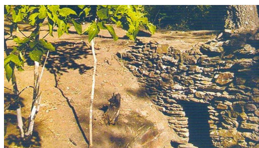
Figura 3 - Estrada calçada que ligava Vila Boa ao Rio de Janeiro: detalhe da passarela de pedra com galeria de água.
