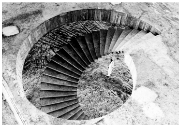
Museu de Arte Moderna do Rio de Janeiro, construção do bloco de exposições, escada que leva ao primeiro pavimento com Francisco Bolonha no pilotis , s/d. (MAM, Núcleo de Documentação) Foto: Aertsens Michel
